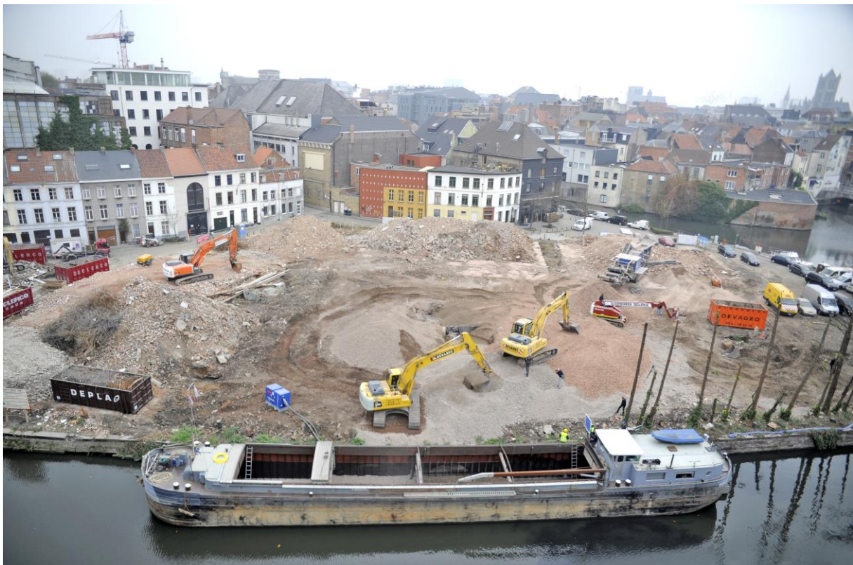
Sloopwerken aan de Waalse Krook
